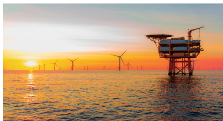
洋上風力向け変電設備群
