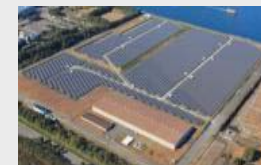
太陽光発電システム
