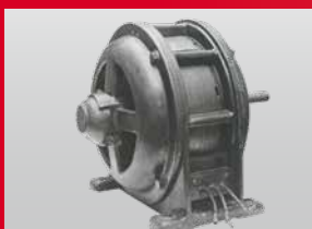
5馬力誘導電動機
