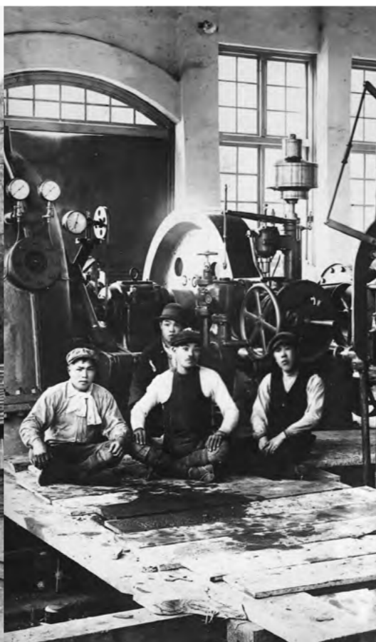
日立鉱山発電所 (1916年撮影)
