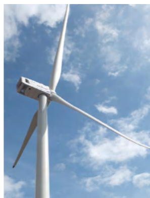
日立ウィンドパワー株式会社 鹿島港深芝風力発電所
